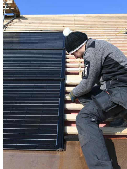
^ Hier montiert Vitor Magalhães Solarzellen direkt auf die Unterkonstruktion.
